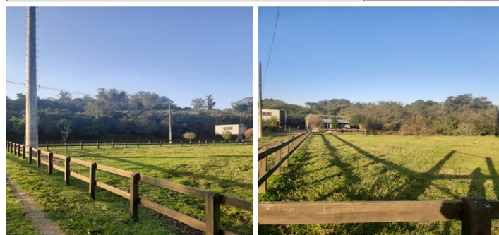
Recintos em fase de construção junto ao Preservas, UFRGS, Porto Alegre.
