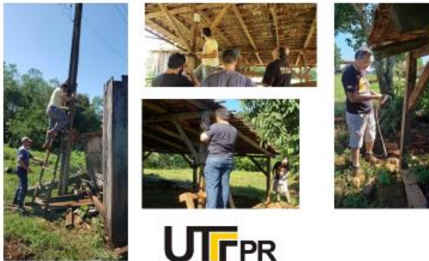
Figura 141 - Instalação do Sistema Turerê.
